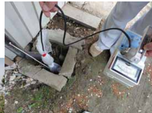
雨水ピット: 65kcpm 土壌を剥離除去
