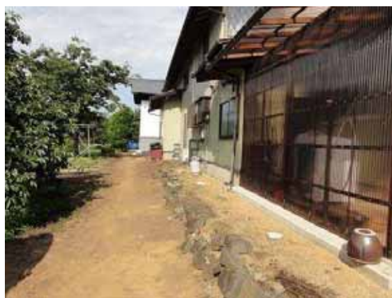
土壌の剥離(手作業)
