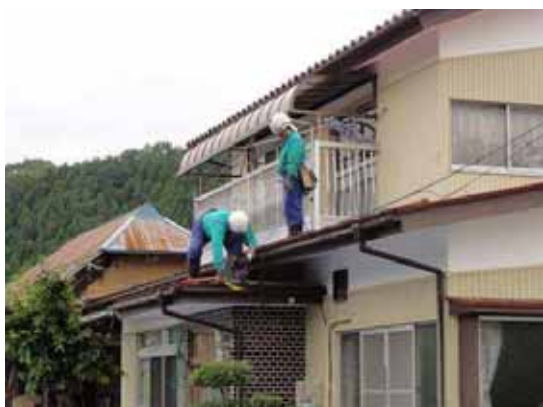
雨樋・屋根の掃除
