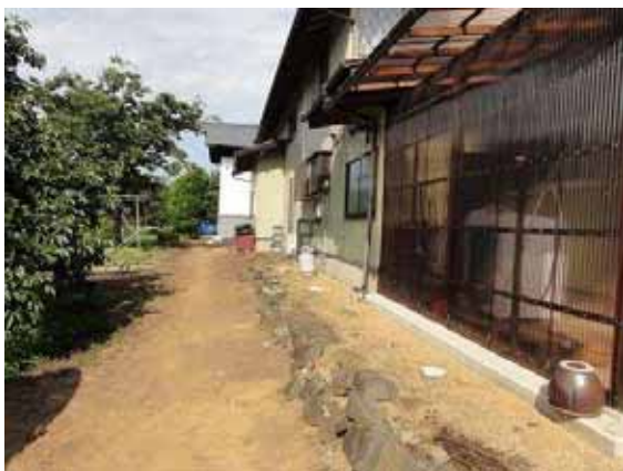
土壌の剥離(手作業)
