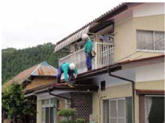
雨樋・屋根の掃除
